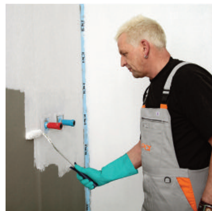
PCI Lastogum nanosi se na podlogu nerazrijeđen pomoću valjka, četke ili lopatice.
