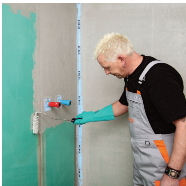
4. Nanijeti prvi zaštitni premaz PCI Lastogum (sivi) na podlogu nerazrijeđen, obilno da se prekrije površina.
