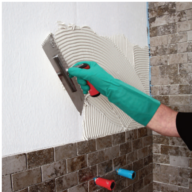
6. Na PCI Lastogum mogu se nakon sušenja lijepiti pločice i ploče.
