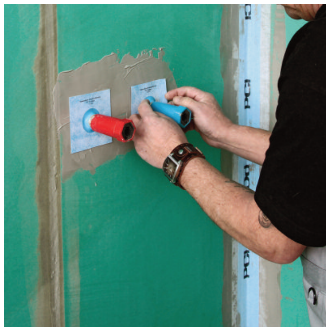
2. Preko priključka cijevi koji izlazi iz zida navući PCI Pecitape 10 x 10 i zalijepiti PCI Lastogumom (sivi).
