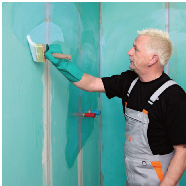
1. Temeljni premaz: Upojne mineralne ili gipsane podloge i gips-kartonske ploče premazati pretpremazom PCI Gisogrund.
