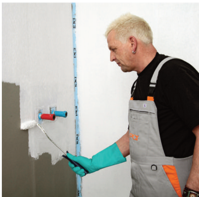
5. Nanijeti drugi zaštitni premaz PCI Lastogum (bijeli) nakon isparavanja od oko 1 sat. Ne smije se providjeti 1. sloj PCI Lastoguma (bijeli); po potrebi premazati još jednom.
